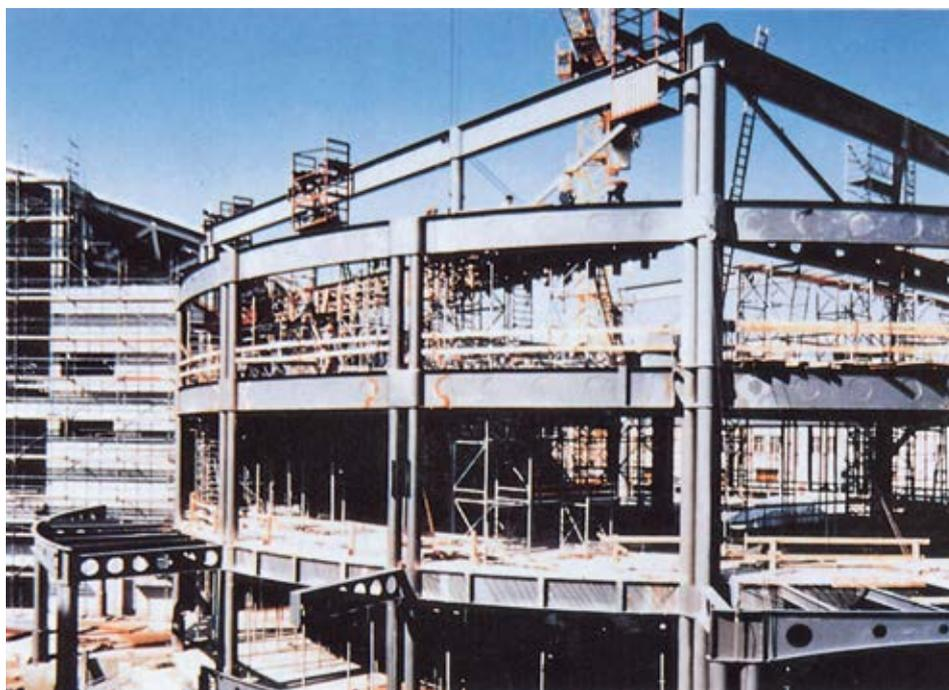
› Betongefüllte Doppelrohrstützen; Eingangsbauwerk Messe Frankfurt
