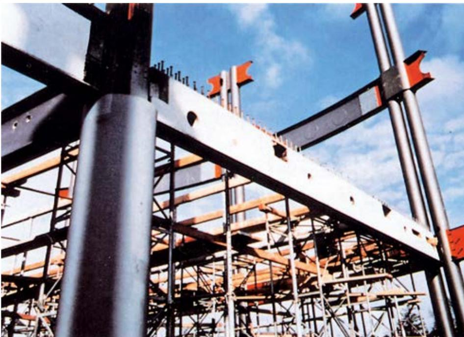
Die Lasteinleitung bei geschosshohen Stützen bereitet i. Allg. keine Probleme, da hier Kopfplatten angeordnet werden können, die als Dübel und damit als Lasteinleitungselemente dienen (Bild 13).
