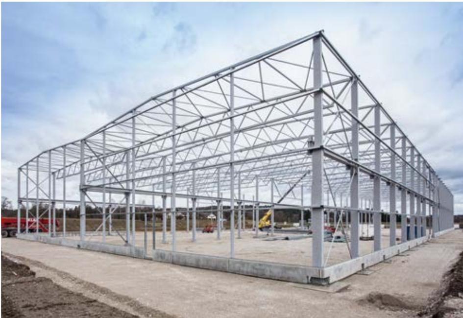
sche Eigenschaften auf, insbesondere bei Druck und Torsionsbelastungen. Dies führt dazu, dass bei Fachwerken aus Hohlprofilen erhebliche Materialeinsparungen gegenüber Fachwerken aus offenen Profilen erzielt werden können. Hinzu kommt die effiziente Verarbeitung, da im Regelfall auf Knoten- und Versteifungsbleche verzichtet werden kann. Schließlich haben Hohlprofilkonstruktionen kleinere Oberflächen als vergleichbare Konstruktionen aus offenen Stahlprofilen.
