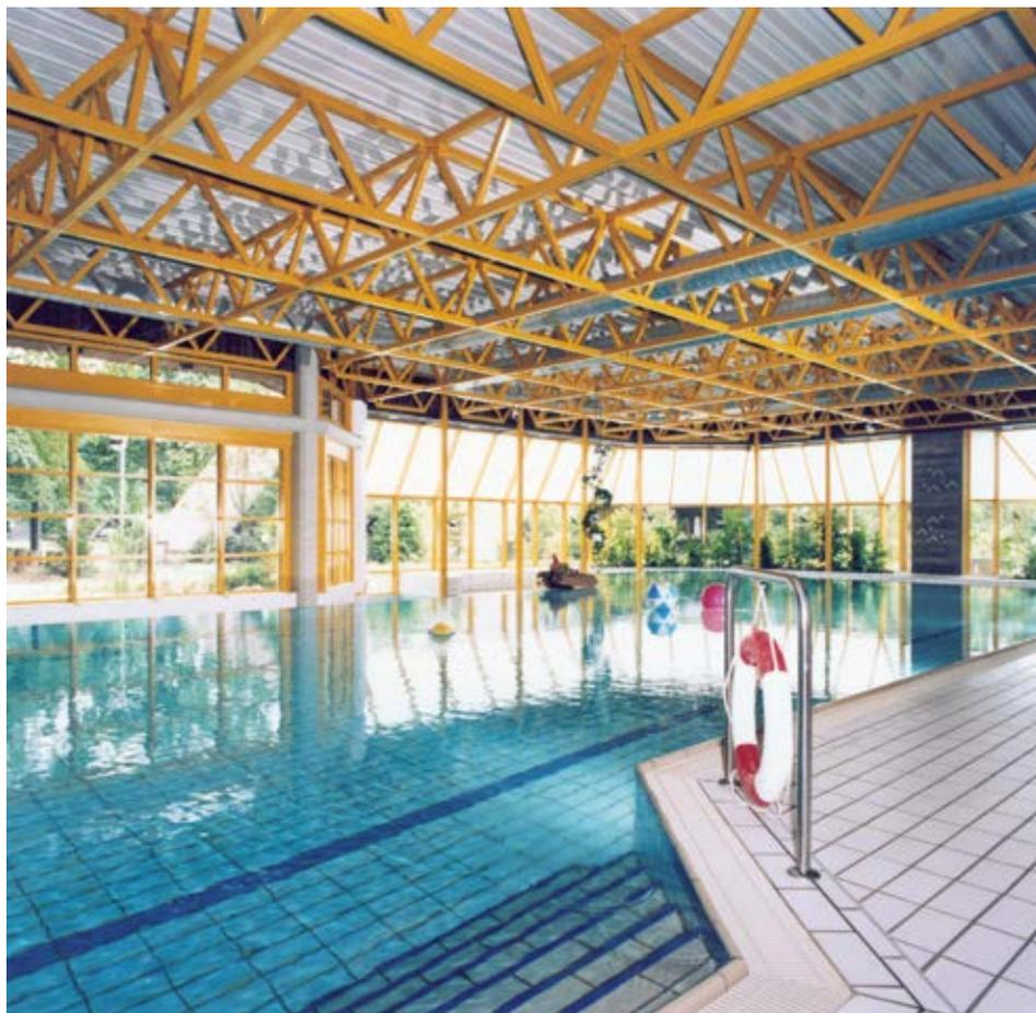
Kreuzweise gespanntes Tragwerk Delta, System Rüter
