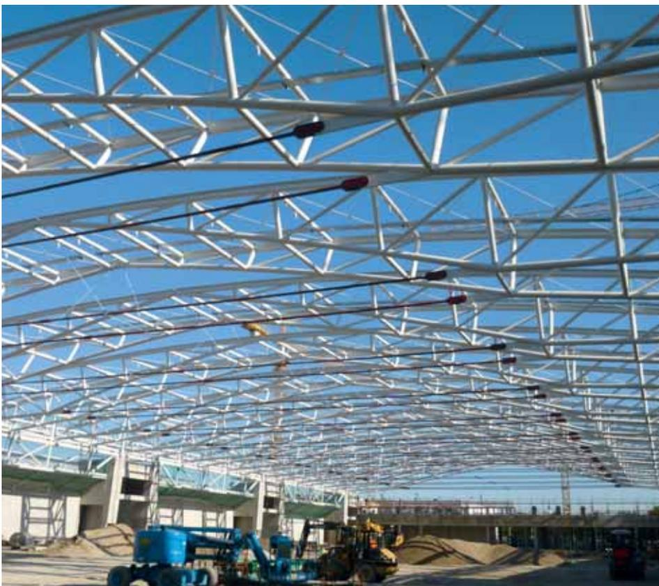
➤ Abb. 5.2: Ebener PREON® box Fachwerkbinder aus MSH-Profilen in einem Flugzeughangar.
